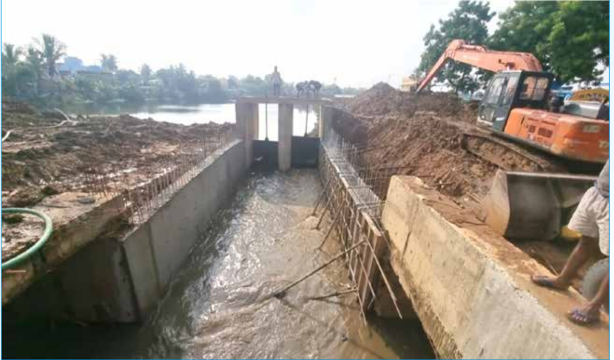
சென்னை மாவட்டம், அயனாவரம் வட்டம், கொளத்தூர் கிராமத்தில் உள்ள கொளத்தூர் ஏரியினை ஆழப்படுத்தி கரைகளை மறு சீரமைத்தல் மற்றும் உபரி நீர் கால்வாயினை மேம்படுத்துதல் பணி. மதிப்பீட்டு தொகை ரூ. 7.30 கோடி
