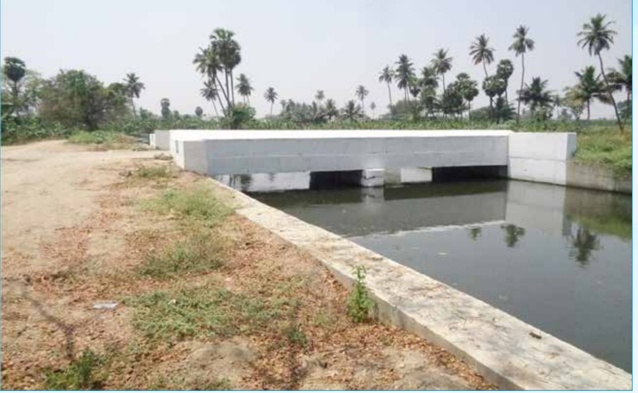
ஈரோடு மாவட்டத்தில், காலிங்கராயன் வாய்க்கால் விரிவாக்குதல், புதுப்பித்தல் மற்றும் நவீனப்படுத்துதல் பணி. மதிப்பீடு : ரூ.76.80 கோடி. காலிங்கராயன் கால்வாயில் மைல் 17/6.5ல் பாலம் மறுகட்டமைப்பு செய்தல்
