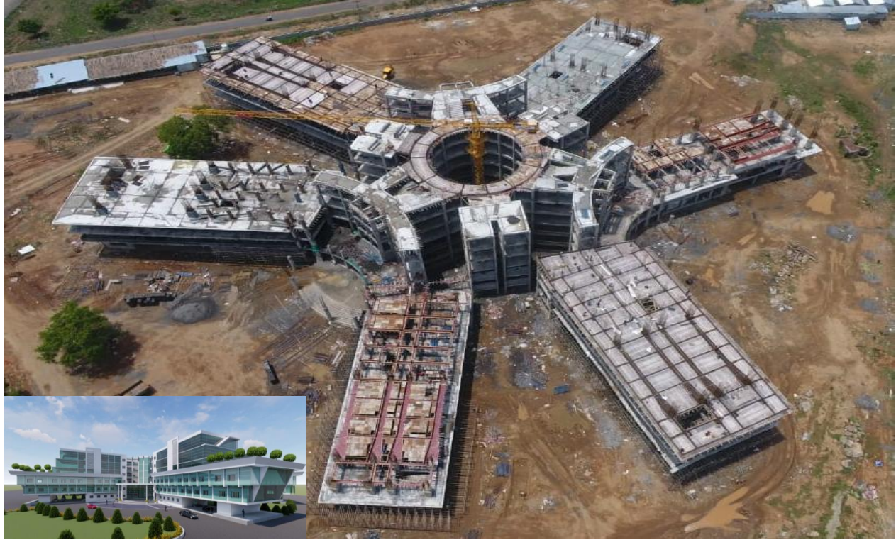
செங்கல்பட்டில் கட்டப்பட்டுவரும் மாவட்ட ஆட்சியர் அலுவலக கட்டடம்
