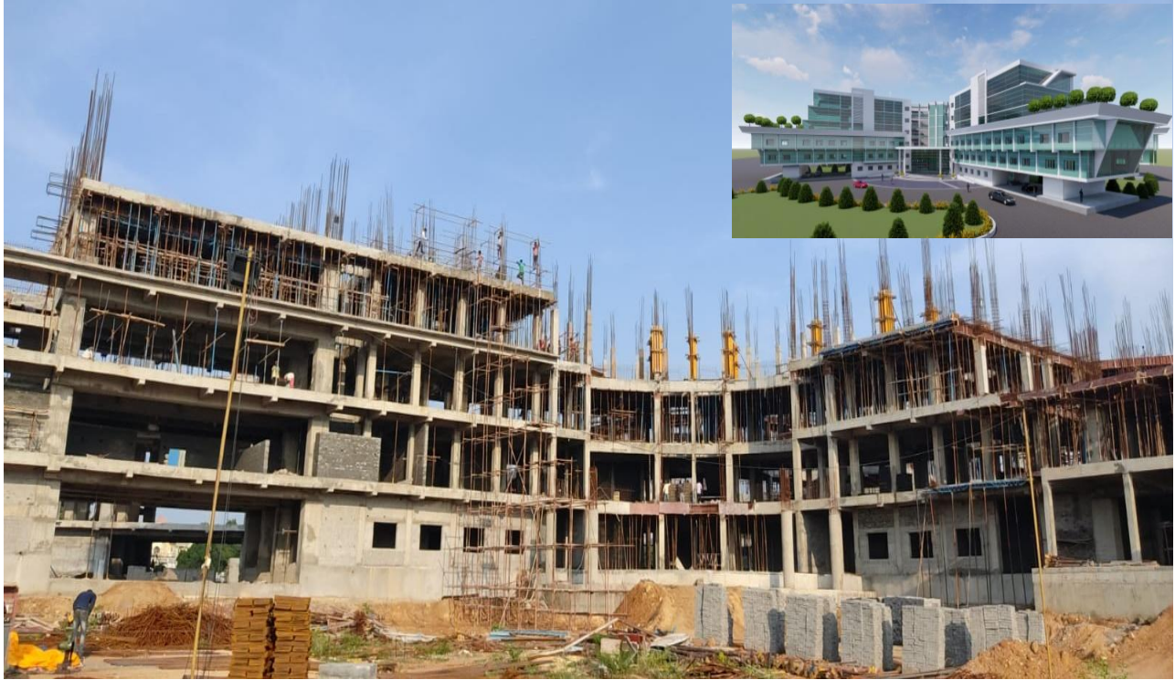
இராணிப்பேட்டையில் கட்டப்பட்டுவரும் மாவட்ட ஆட்சியர் அலுவலக கட்டடம்
