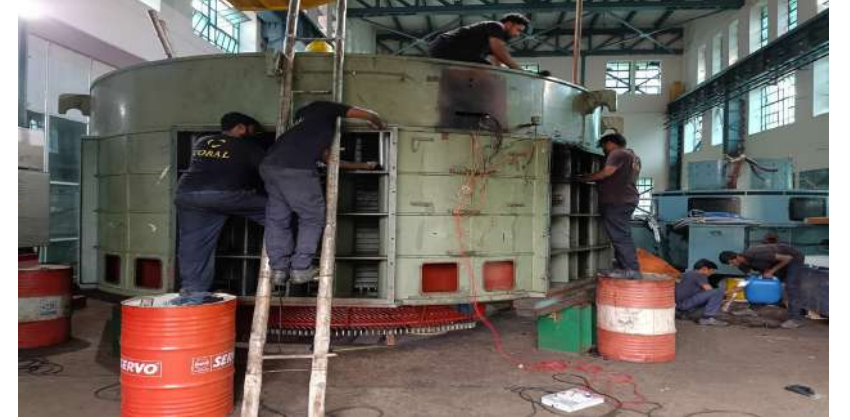
கோதையார் புனல் மின் நிலையம் -II-ல் பழுதடைந்த ஸ்டேட்டர் சுருளினை (Stator coils) மாற்றி அமைத்தல்
