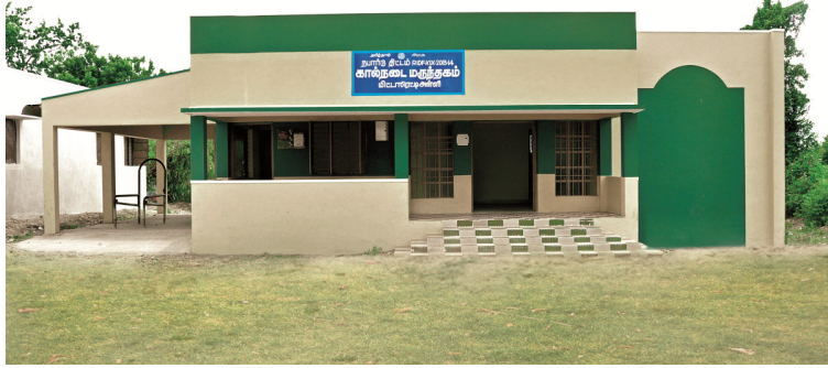
நபார்டு திட்ட ஊரக உட்கட்டமைப்பு மேம்பாட்டுத் திட்டத்தின்கீழ் கட்டப்பட்டுள்ள கால்நடை மருந்தகக் கட்டிடம் - மிட்டாரெட்டி ஹள்ளி, தர்மபுரி மாவட்டம்
